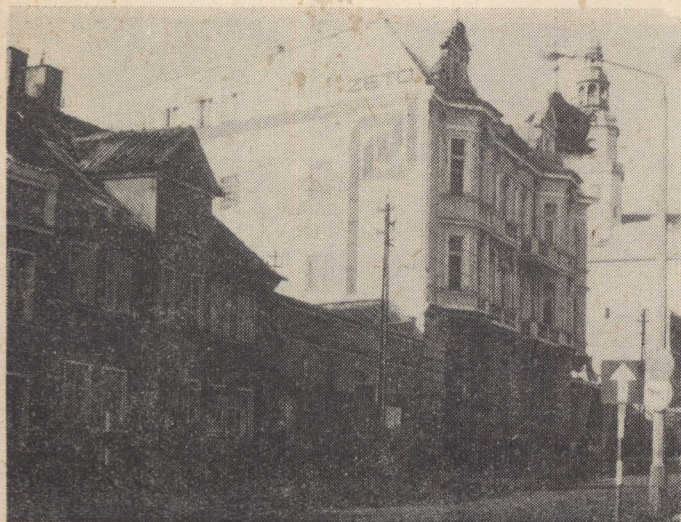
ZETO OLSZTYN — budynek ośrodka obliczeniowego
