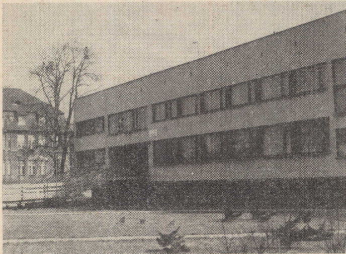
ZETO SZCZECIN — budynek ośrodka obliczeniowego
