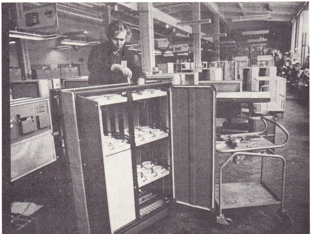
1. Montaż mechaniczny maszyny cyfrowej typu Odra 1325 i Odra 1305
