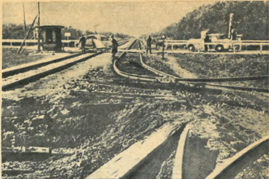
Tory kolejowe koło Warszawy zniszczone bombami niemieckimi.
