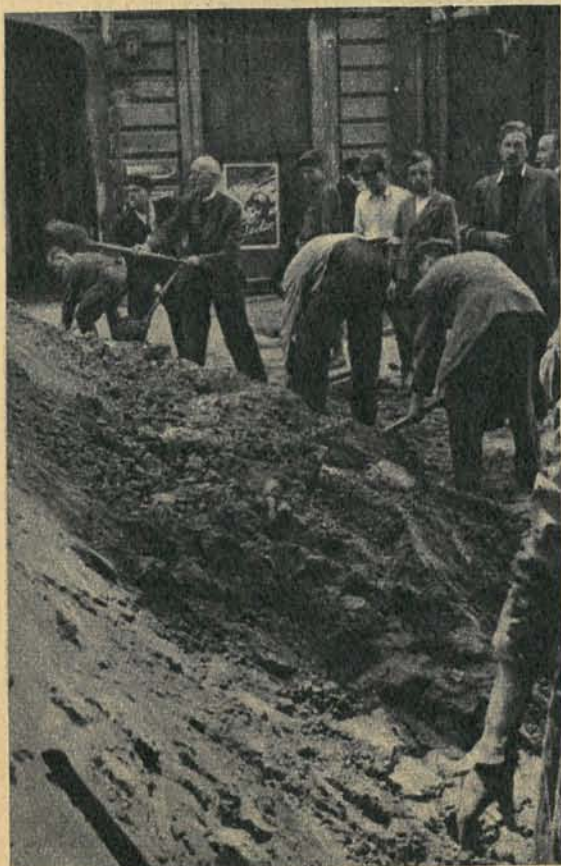
Kto żyw — ruszył na ulicę do budowy barykad i rowów przeciwczołgowych. Na zdjęciu: grupa mieszkańców północnej części Śródmieścia przy pracy.
