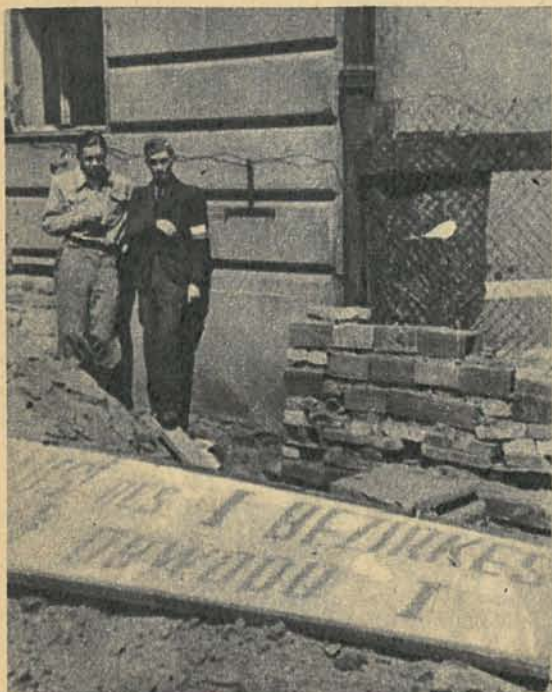
Znienawidzony napis niemiecki zerwano z gmachu Ubezpieczalni na ul. Smulikowskiego. Z ręką na temblaku ppor. „Nowina”, d-ca plutonu uderzającego na most średnicowy ze zgrupowania III por. „Konrada”, obok niego — pchor. „Rudzki”.
