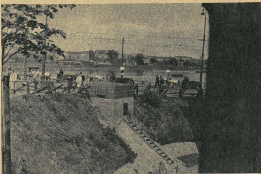
...do przeprawy przez mosty na Wiśle. Na zdjęciu: umocnienia przy moście Kierbedzia — otwór strzelniczy zwrócony w kierunku Nowego Zjazdu.
