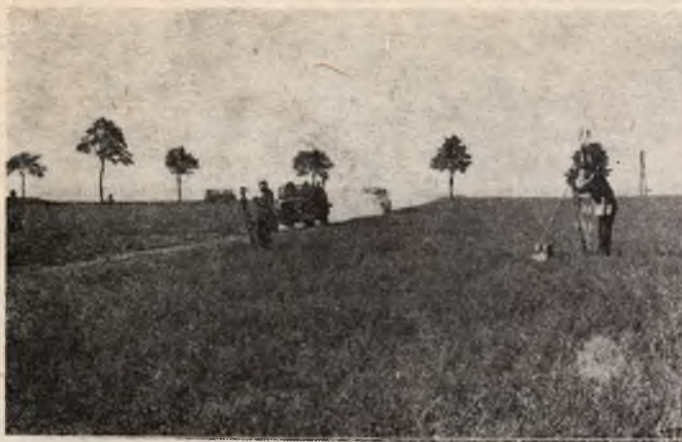
Rys. 4. Pierwsze prace miernicze na terenie przyszłej budowy kombinatu
