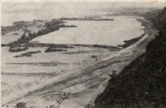
Rys. 3. Przygotowanie nabrzeża Wisły do budowy przypory piaskowej skarpy
