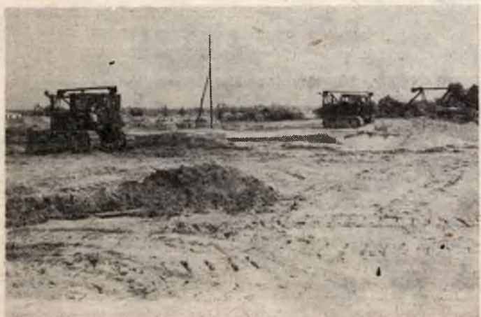
Rys. 5. Niwelacja terenu pod budowę pierwszych obiektów
