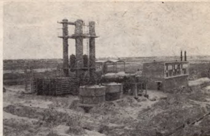
Rys. 6. Montaż pierwszych instalacji technologicznych
