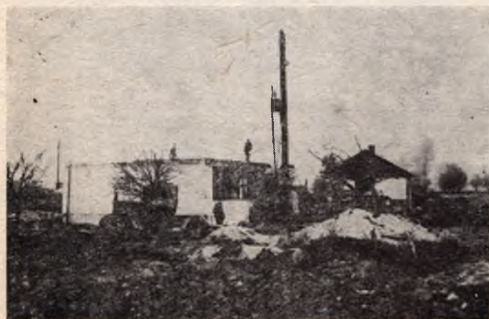
Rys. 8. Tak rozpoczynała się budowa
