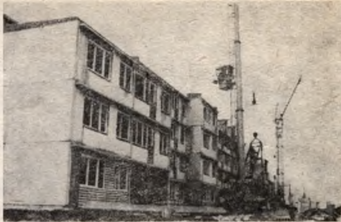
Rys. 9. Pierwsze budynki mieszkalne na osiedlu „Dobrzyńska”
