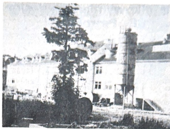
Rys. 12. Pawilon szpitalny przy ul. Kościuszki w Płocku (w budowie)
