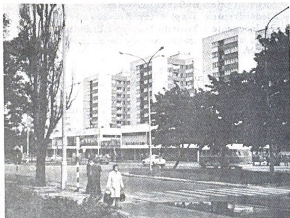
Rys. 10. Osiedle Tysiąclecia w Płocku realizowane przez PBP „PETROBUDOWA” Fot. Jerzy Fall
