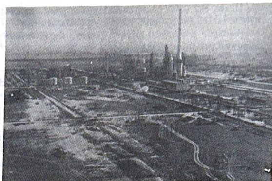
Rys. 2. Ogólny widok budowy Kombinatu
