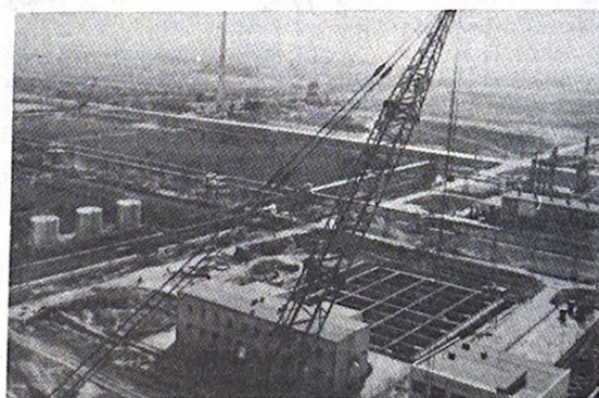
Rys. 3. Ogólny widok budowy Kombinatu
