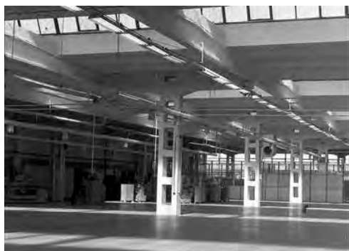
49. Hala produkcyjna zakładu w Siedlcach
