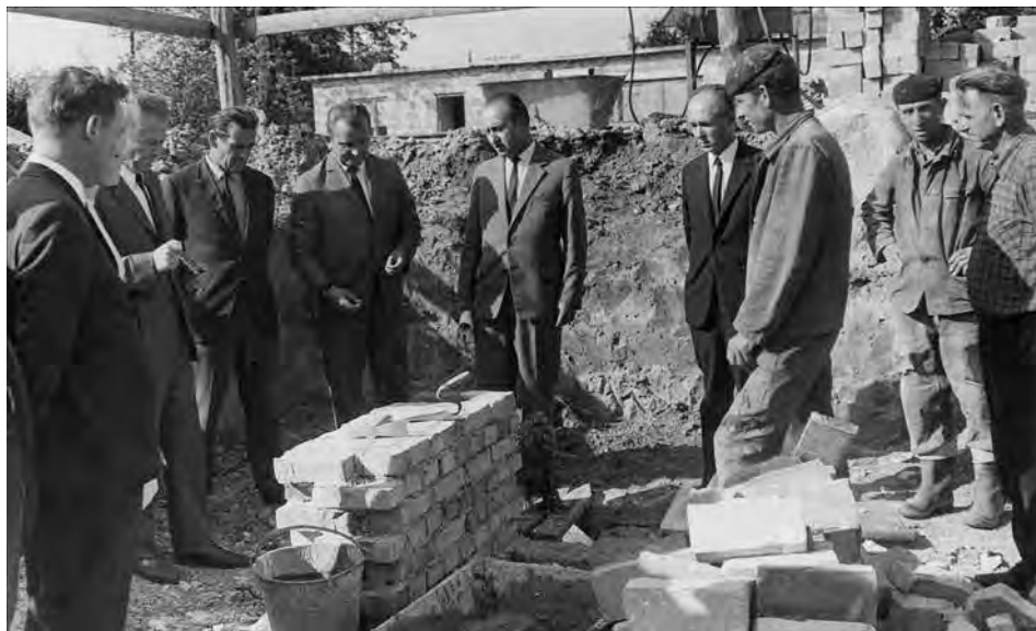
44. Wmurowanie aktu erekcyjnego pod budynek zaplecza
