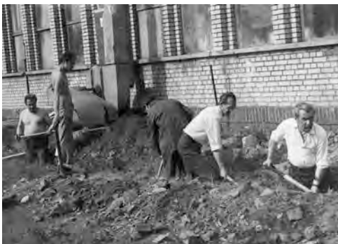
133. Czyn społeczny przy budynku hali montażu drukarek
