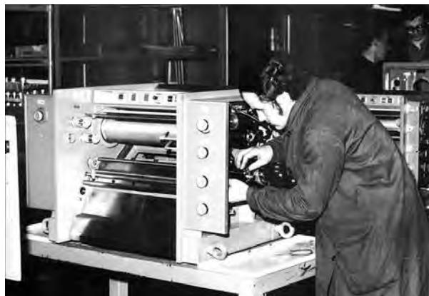
60. Montaż mechanizmu 666/V3 szybkiej drukarki wierszowej
