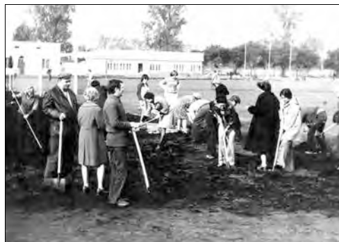
130. Przy budowie stadionu
