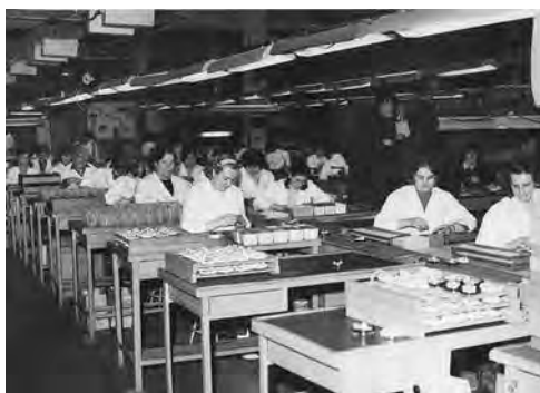
50. Linia montażu tarczy telefonicznej
