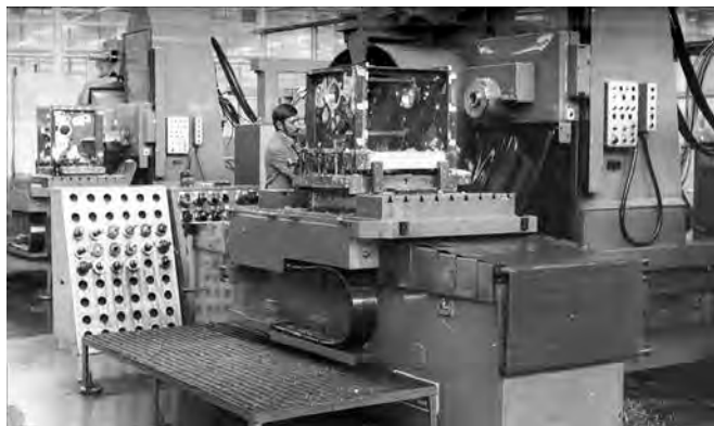
64. Obróbka korpusu mechanizmu drukarki w centrum obróbczym H6B firmy Mitsui-Seiki
