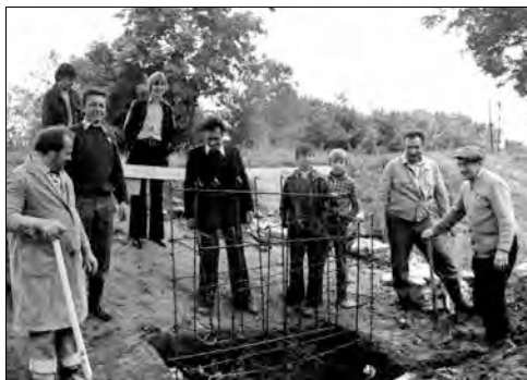
131. Budowa kładki nad Rokitnicą
