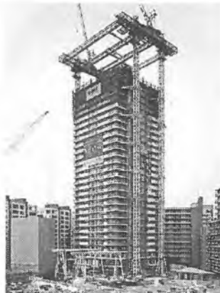
Rys. 4. Zautomatyzowany system wznoszenia budynków - Smart [15]
