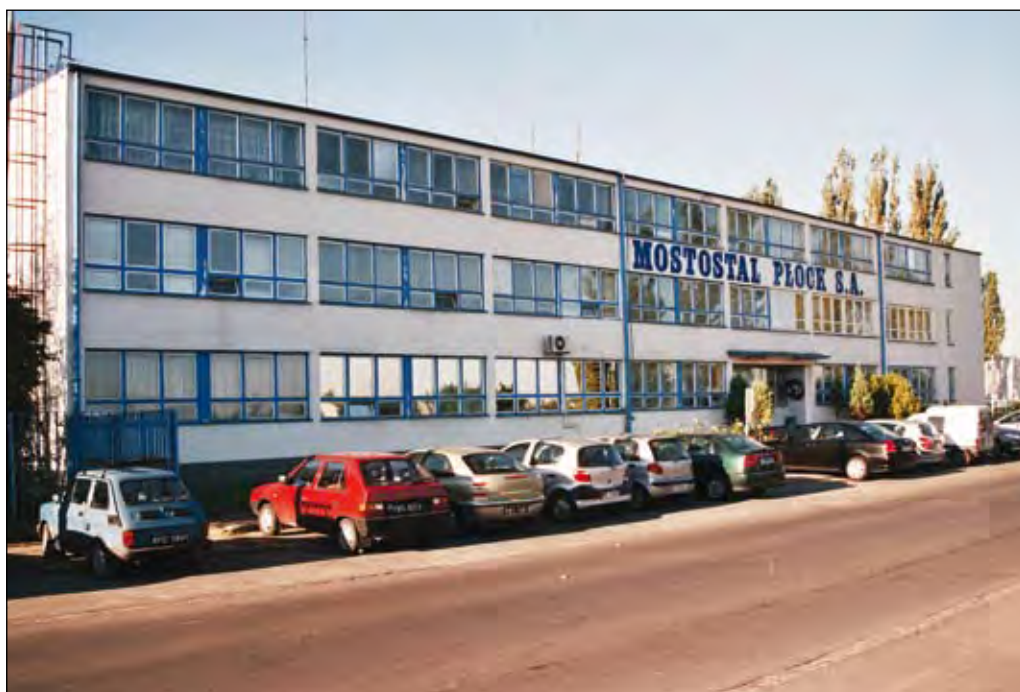
Fot. 86. Budynek biurowy Mostostal Płock SA. przy ulicy Targowej
