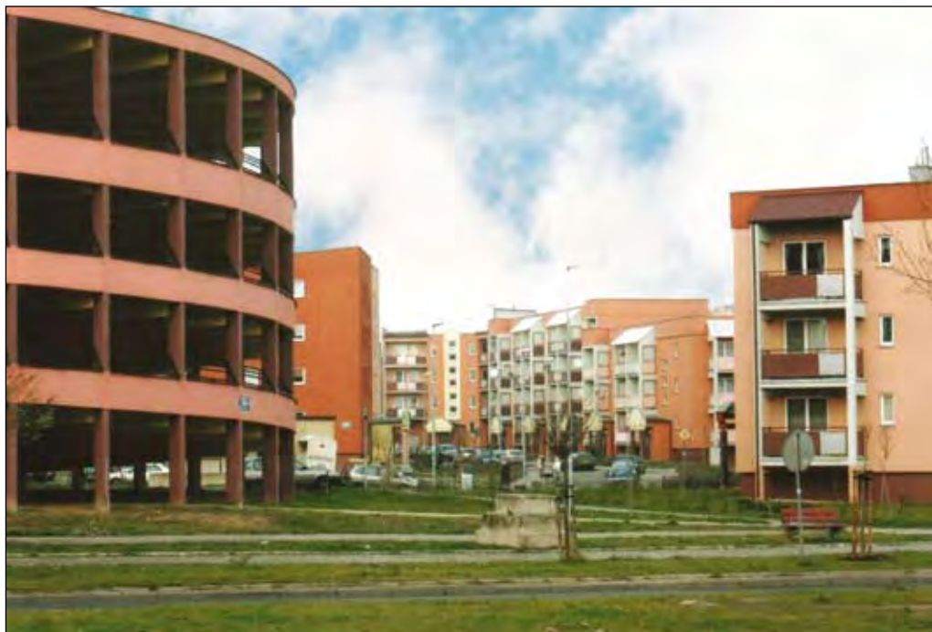
Fot. 147. Osiedla MTBS w dzielnicy Podolszyce Południe
