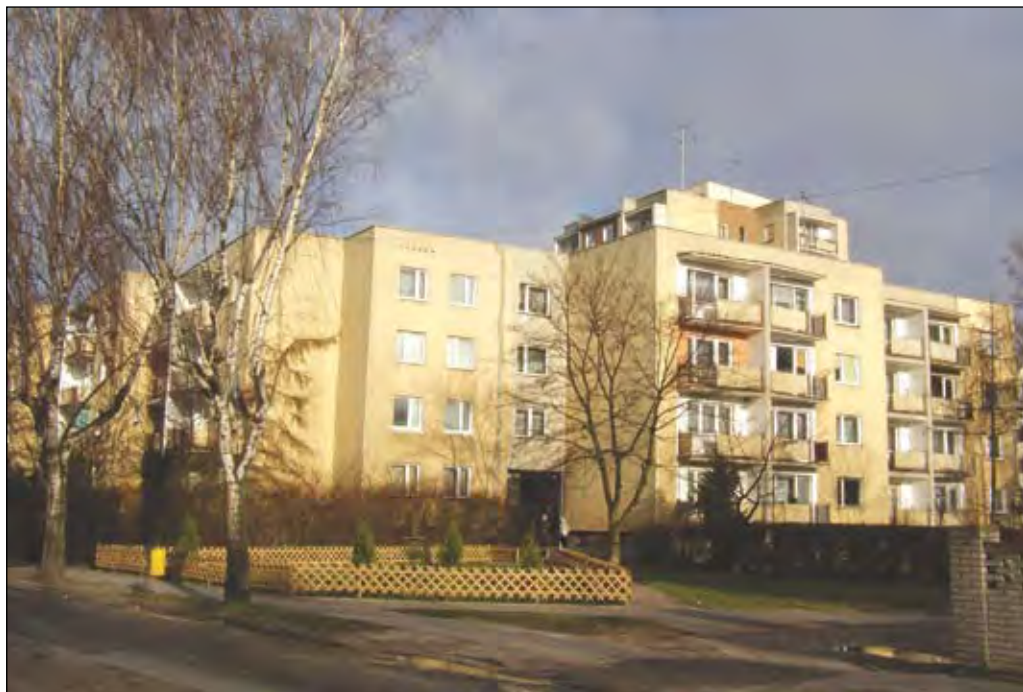
Fot. 143. Budynki mieszkalne przy ul. 3 Maja
