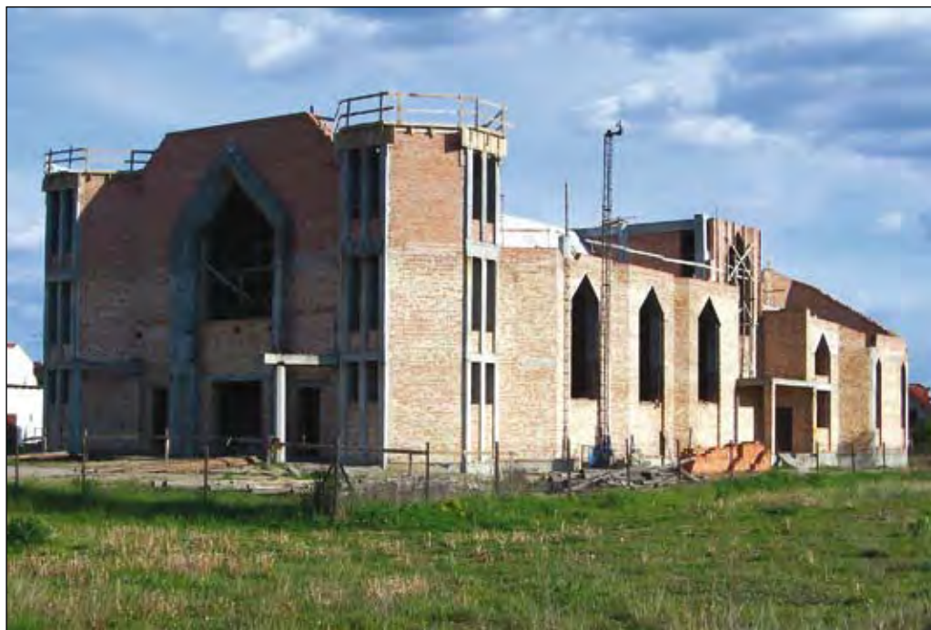
Fot. 36. Kościół pw. św. Wojciecha na Podolszyczach Południu w budowie
