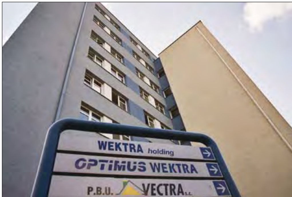
Fot. 81. Budynek biurowy przy ul. Otolińskiej, dawna siedziba dyrekcji Fabryki Maszyn Żniwnych
