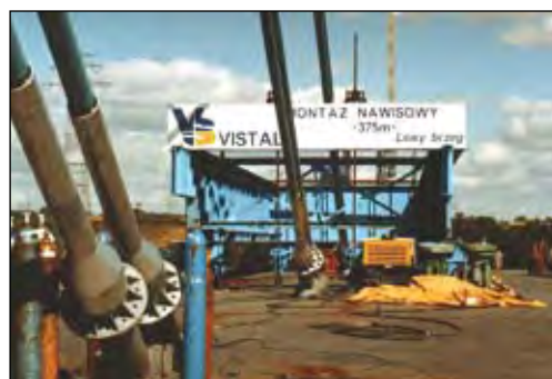
Fot. 50. Mocowanie odciągów pylonów
