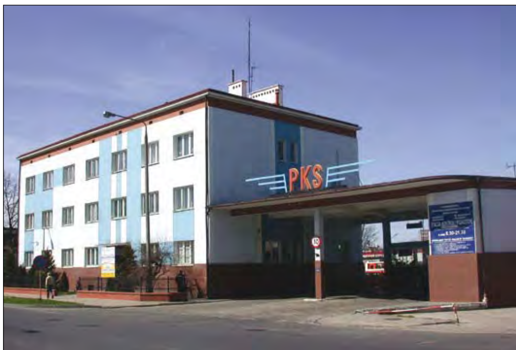
Fot. 94. Siedziba dyrekcji płockiego PKS przy ul. Bielskiej
