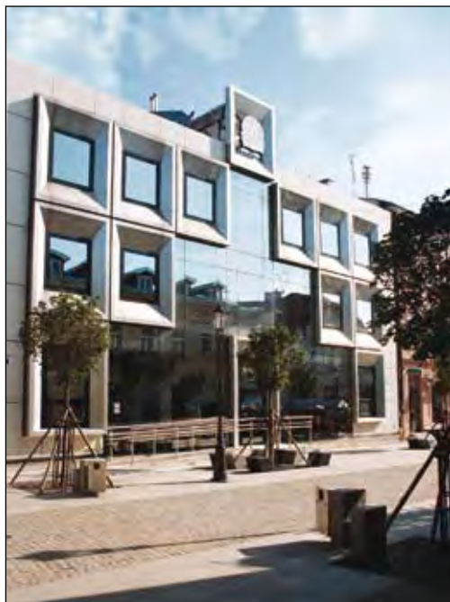
Fot. 87. Budynek PZU Życie przy ul. Tumskiej wtopiony w klasycystyczną zabudowę
