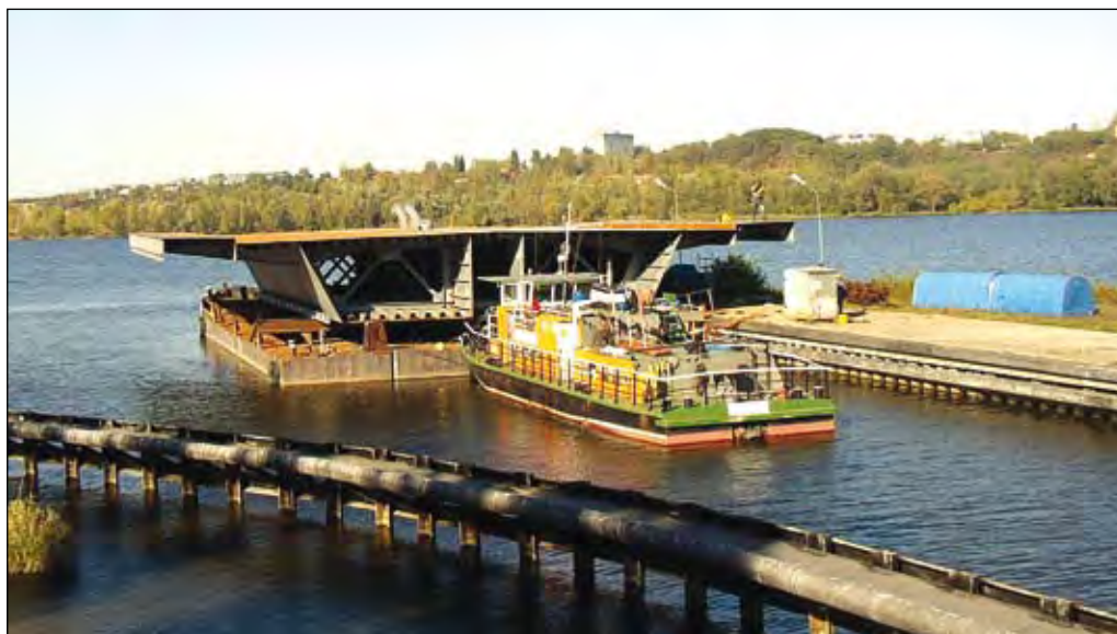
Fot. 51. Transport Wisłą przęseł mostu
