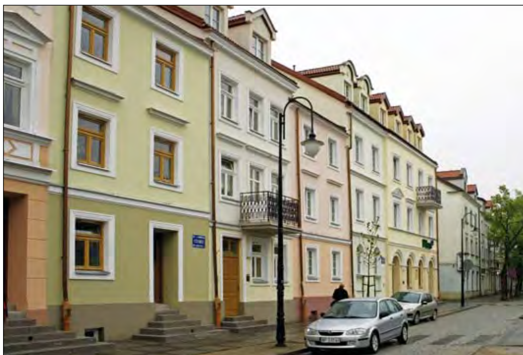
Fot. 22. Ten sam fragment ul. J. Kwiatka po restauracji — elewacja frontowa
