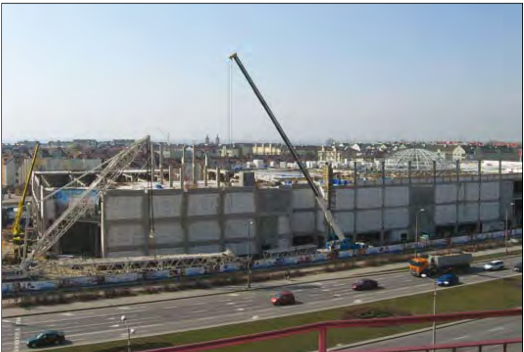
Fot. 152. Budowa galerii handlowo-rozrywkowej Wisła. Stan z wiosny 2008
