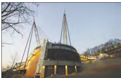
Fot. 57. Modernizacja amfiteatru. Montaż pylonów
