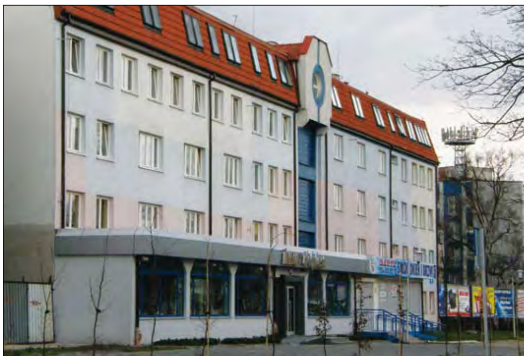
Fot. 109. Budynek po renowacji przy al. J. Kilińskiego
