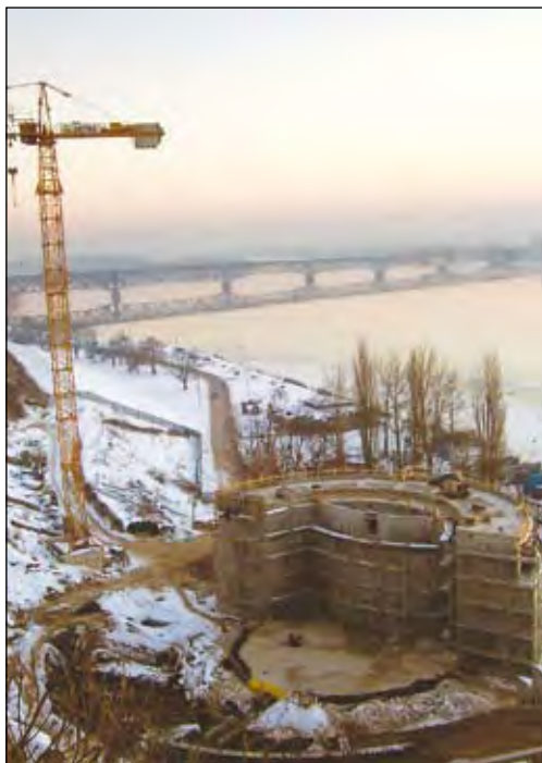
Fot. 58. Amfiteatr płocki. Budowa zaplecza sceny
