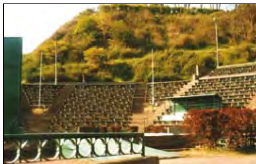
Fot. 56. Amfiteatr płocki przed przebudową
