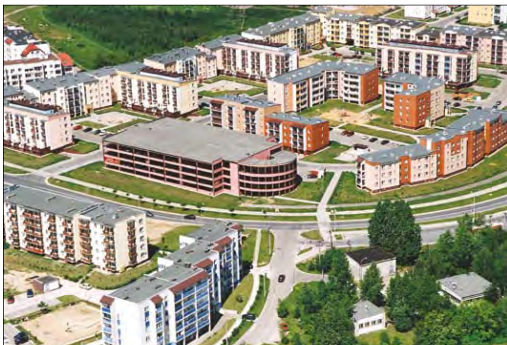
Fot. 148. Osiedla MTBS. W centrum garaż wielopoziomowy
