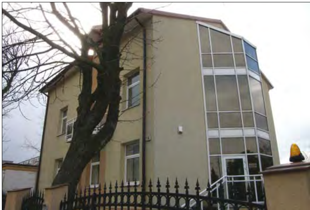
Fot. 139. Budynek biurowy przy ul. Dworcowej
