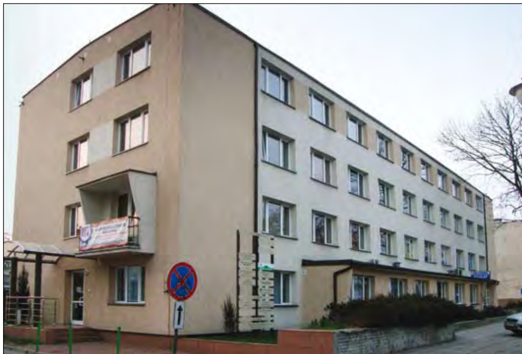
Fot. 105. Budynek spółki Rynex przy ul. 1 Maja. Siedziba oddziału NOT w Płocku oraz MOIB
