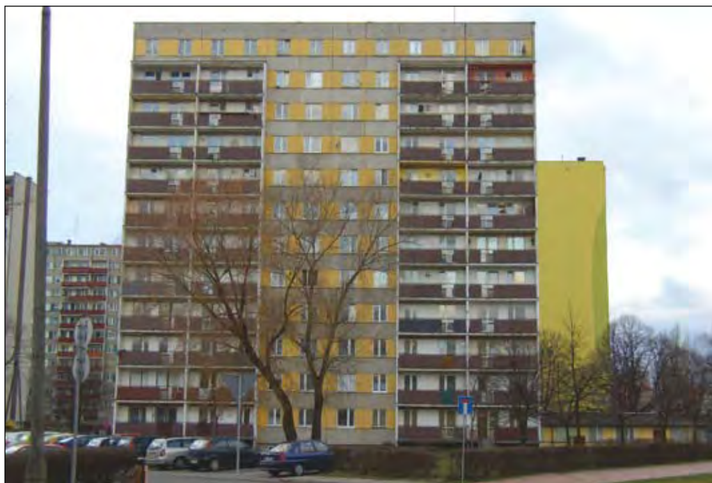
Fot. 132. Wieżowiec przed termomodernizacją przy ul. Dworcowej
