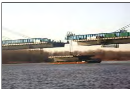
Fot. 49. Moment połączenia obu przęseł mostu
