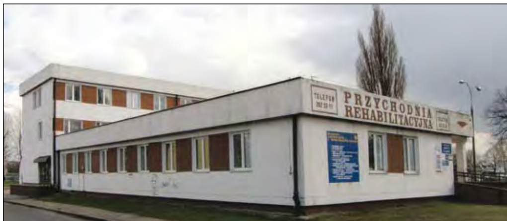
Fot. 91. Przychodnia rehabilitacyjna Spółdzielni Nowator przy ul. Dworcowej.
