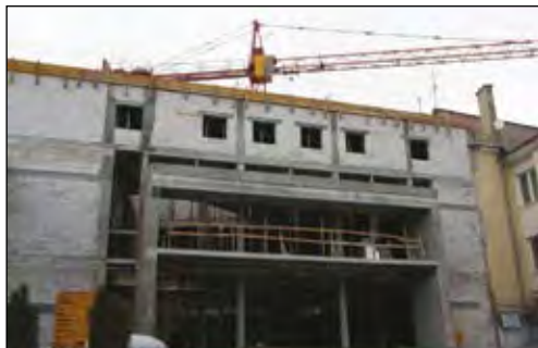
Fot. 65. Budowa kina Nove Przedwiośnie
