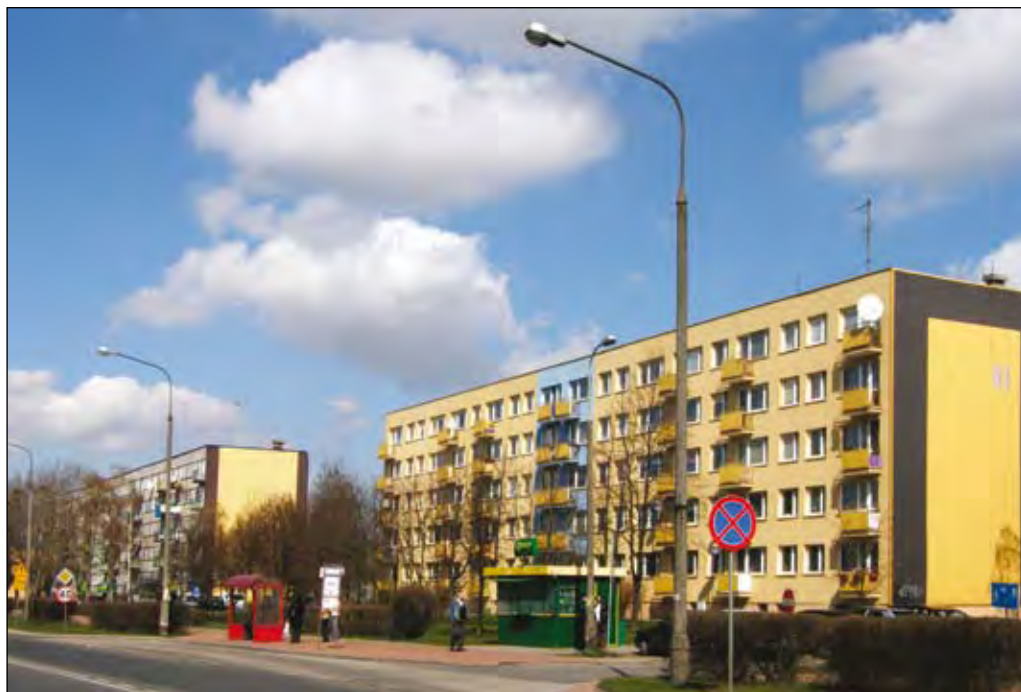
Fot. 114. Budynki mieszkalne przy ul. F. Chopina
