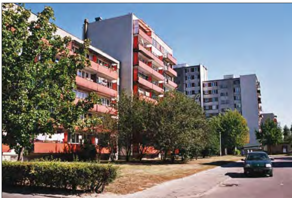
Fot. 150. Osiedle Mazowieckiej Spółdzielni Mieszkaniowej przy ulicy Szarych Szeregów
