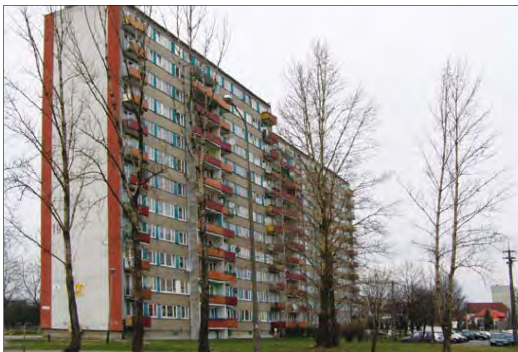
Fot. 127. Wieżowiec przy ul. A. Mickiewicza
