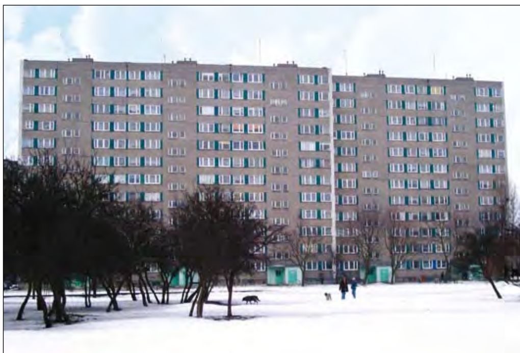
Fot. 111. Zabudowa wielomieszkaniowa przy ul. A. Mickiewicza
