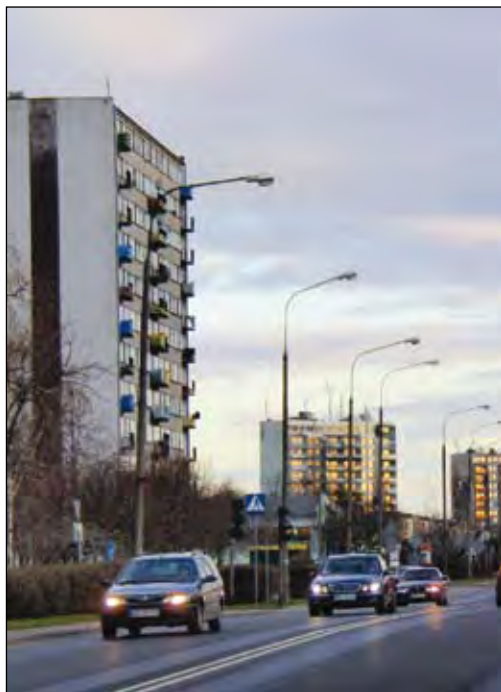
Fot. 107. Wysoka zabudowa przy ul. F. Chopina
