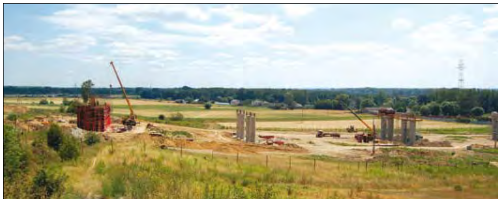
Fot. 48. Tereny zalewowe nad Wisłą. Pierwsze podpory nowego mostu
