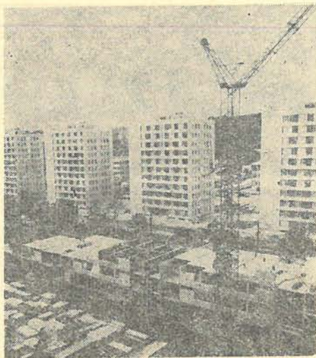
Rys. 2. Budowa osiedla mieszkaniowego w Budapeszcie
