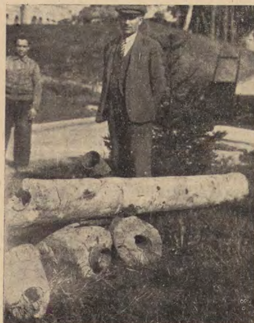
Odkopane rury, stosowane do zasilania miasta w wodę w 1535 roku (Błona)
