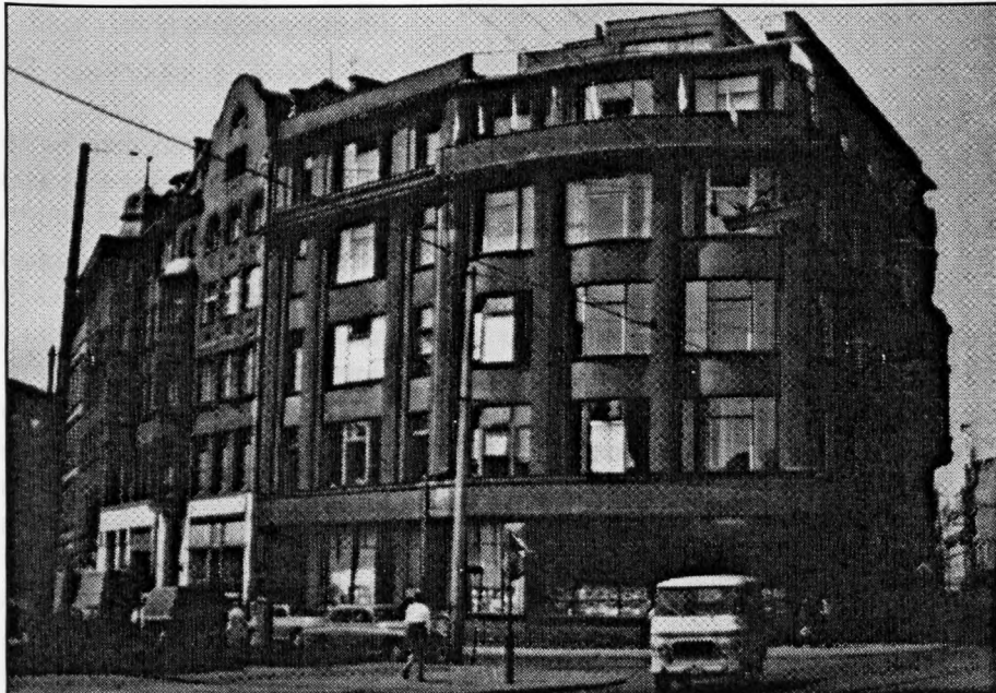
Budynek po zakończeniu odbudowy w 1967 roku
