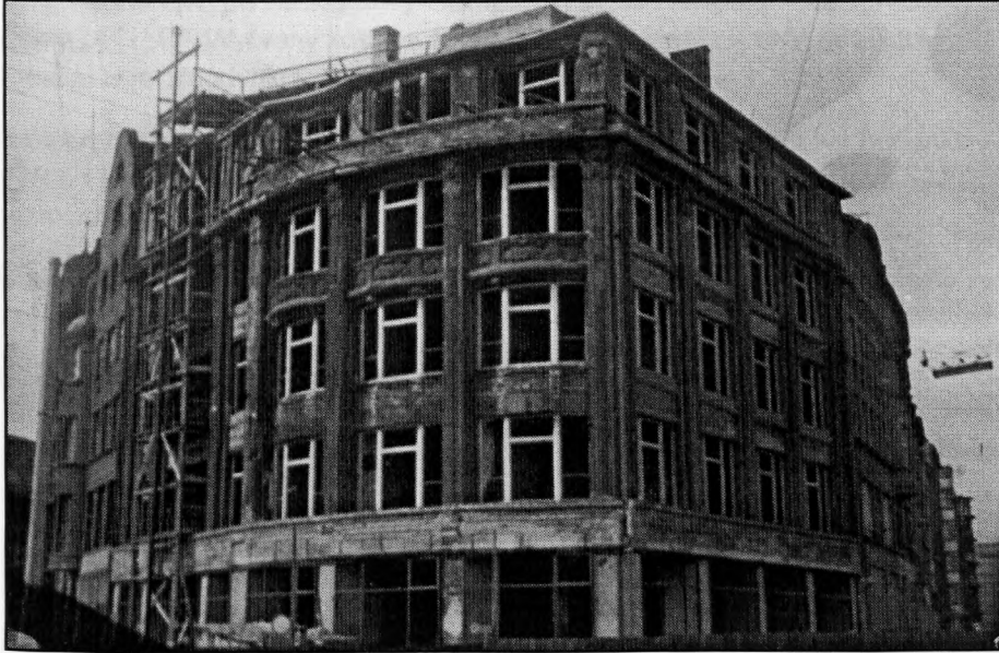
Budynek w trakcie odbudowy - wiosna 1966 r.
