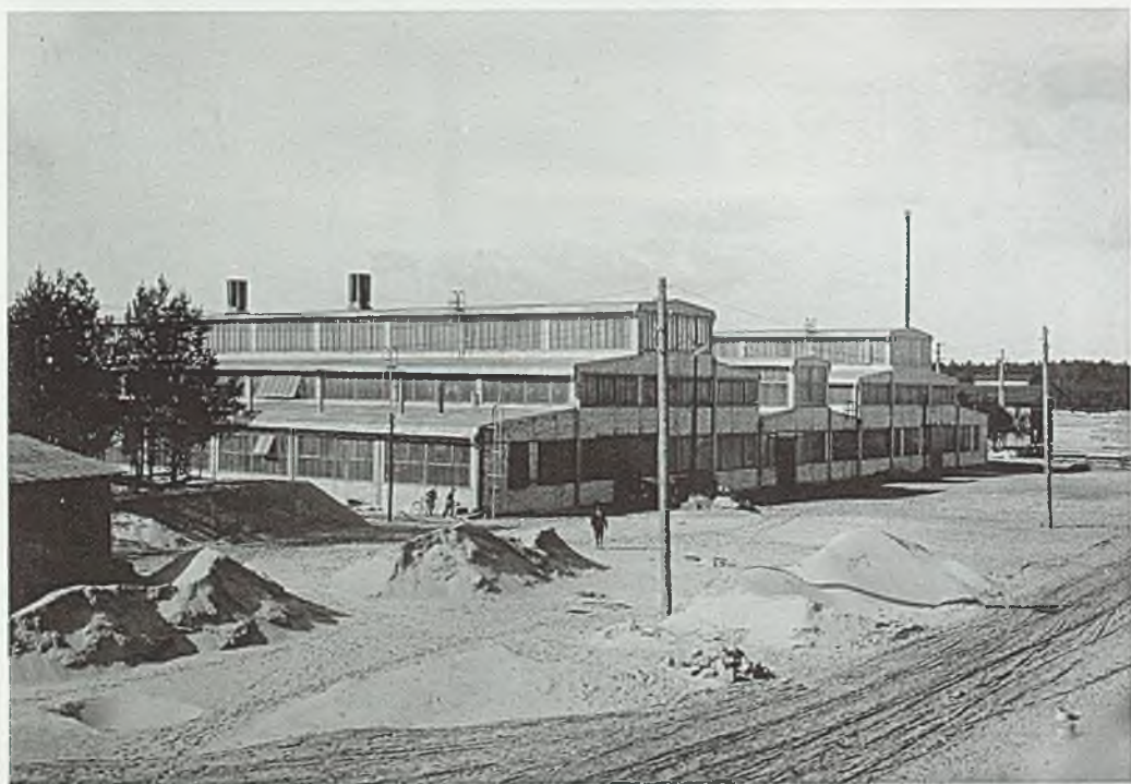
Budowa hal Zakładów Południowych (1938 r.)
