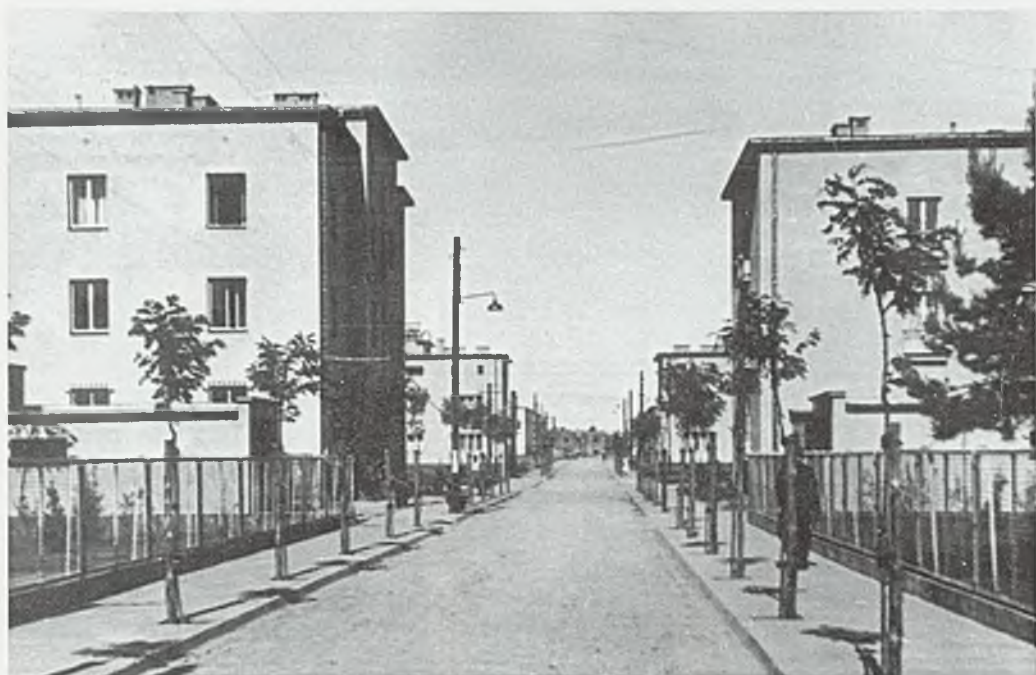
Fragment nowego osiedla w Stalowej Woli (1939 r.)
