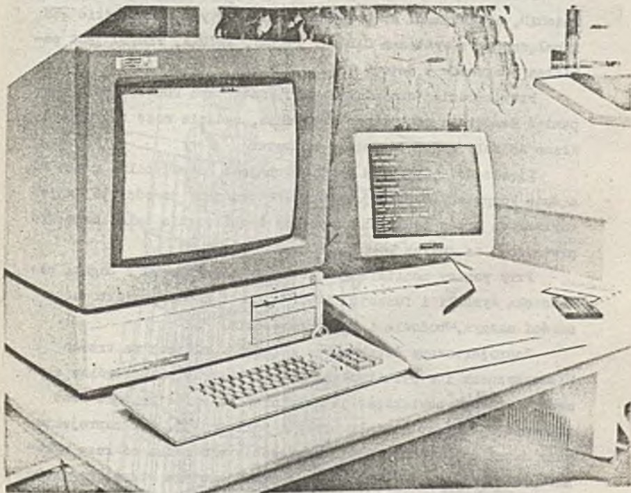
Rys. 5 Stanowisko pracy inżyniera projektanta, monitor ekranowy graficzny 1024*780 punktów, z klawiaturą, digitizer z piórem stykowym i monitor mały alfanumeryczny, pod ekranem monitora graficznego stacja dysku elastycznego.
