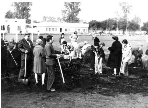
135. Przy budowie stadionu
