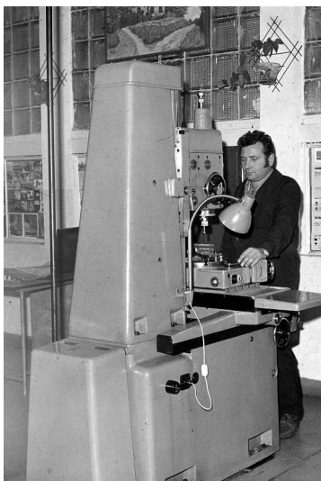
79. Narzędziowiec Ryszard Cieślak pracuje na wytaczarce współrzędnościowej firmy SIP (Szwajcaria)
