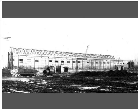
232. Hala montażu P-2 w budowie
