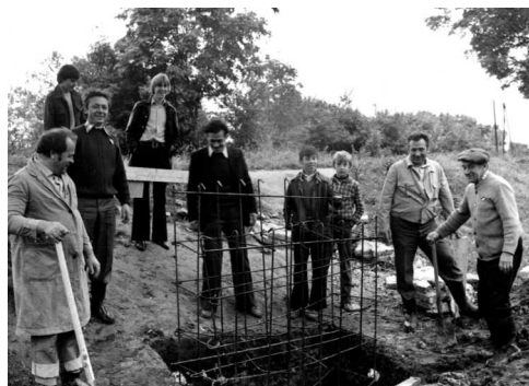
136. Budowa kładki nad Rokitnicą
