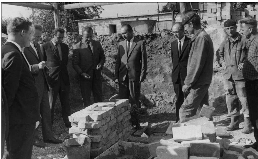
48. Wmurowanie aktu erekcyjnego pod budynek zaplecza
