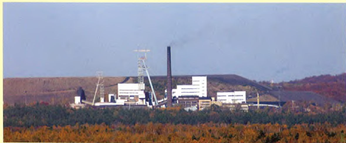
Widok z najwyższych pięter ZEG-u w kierunku kopalni "MURCKI"-Ruch "Boże Dary" (położonej w południowej dzielnicy Katowic - Kostuchnie), widzimy pięknie ukształtowaną, zieloną i zalesioną bryłę, wkomponowaną w krajobraz otaczających ją lasów, która powstała jako ekologiczne składowisko skały płonnej wspomnianej kopalni.
