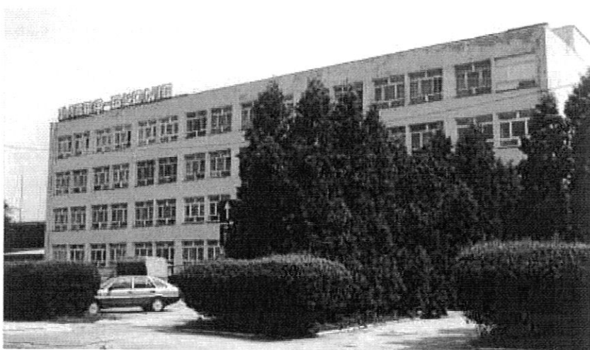
51. Biurowiec zaplecza techniczno – administracyjnego, lata 70.
