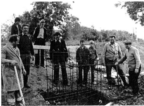
135. Budowa kładki na rz. Rokitnica
