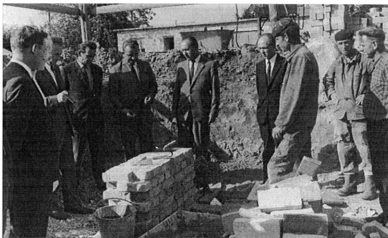
49. Wmurowanie aktu erekcyjnego pod budynek zaplecza.
