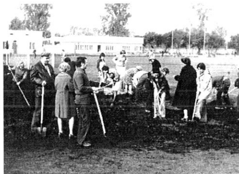
134. Przy budowie stadionu
