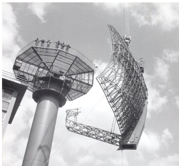
Montaż anteny radaru Avia C w Czechosłowacji
