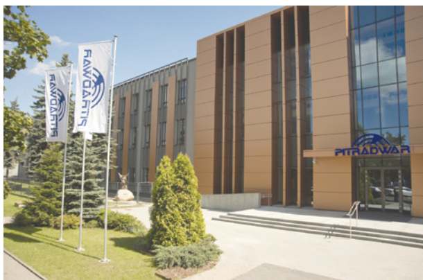
Wejście do odnowionej siedziby PIT-RADWAR
