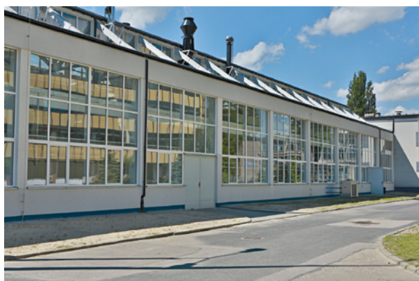
Budynek i wnętrze nowej galwanizerni
