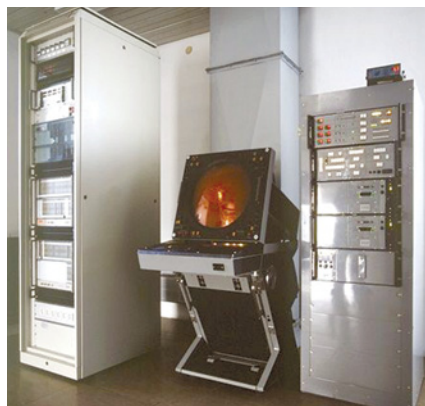
Kabina operatora stacji Avia CM w wieży pod anteną
