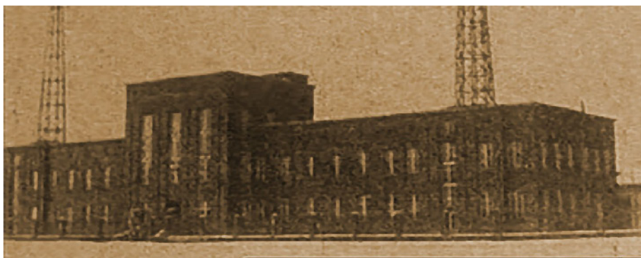
Siedziba PIT w latach 1940.
