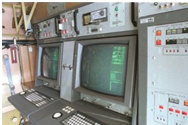
Wnętrze kabiny N 21MI
