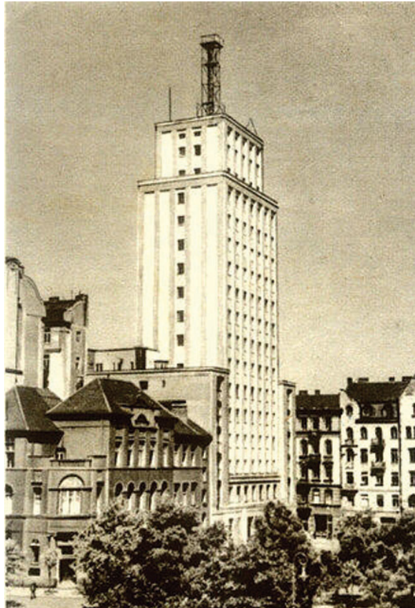
Najwyższy przedwojenny budynek w Warszawie – Prudential – posłużył jako punkt montażu eksperymentalnej anteny telewizyjnej
