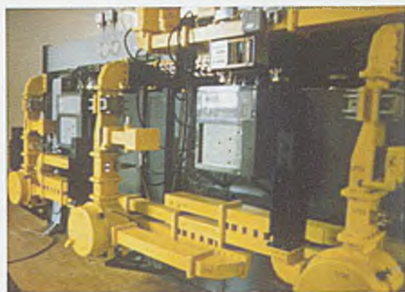
Rys. 9.4. Falowodowy trakt nadawczo-odbiorczy stacji AVIA CM
