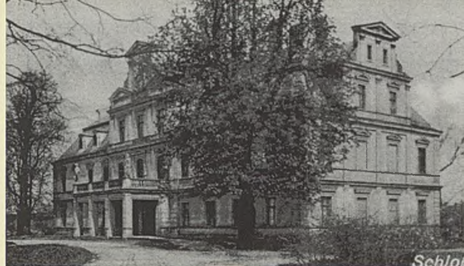
◀ Siedziba rodziny Welczków w Łabędach, ostatecznie rozebrana po wojnie
