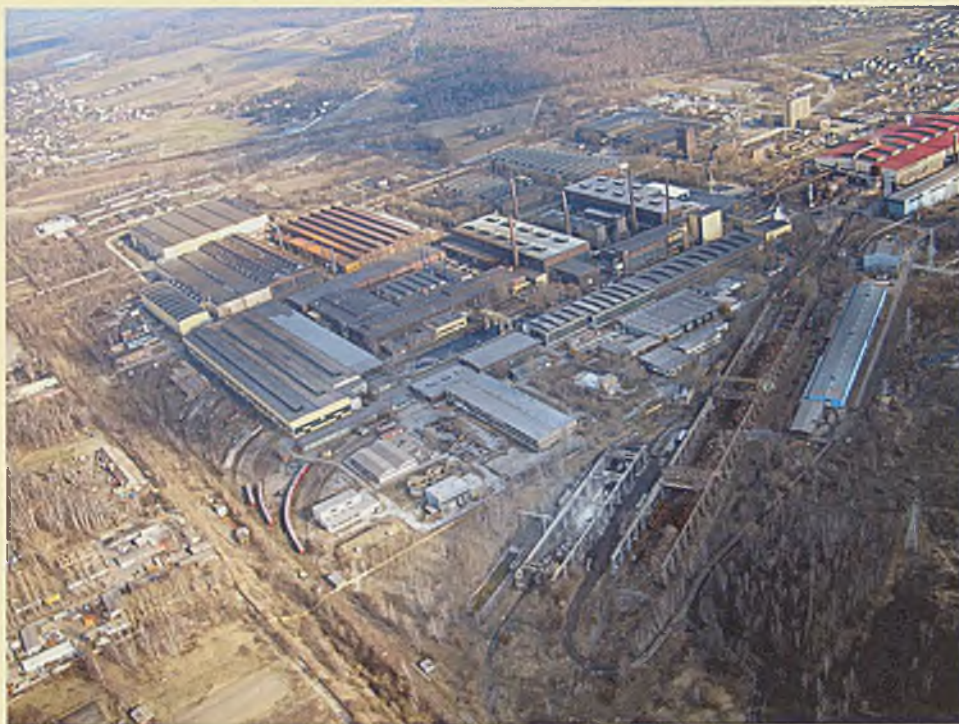
ZM Bumar-Łabędy S.A. – widok z lotu ptaka, kwiecień 2006 roku
