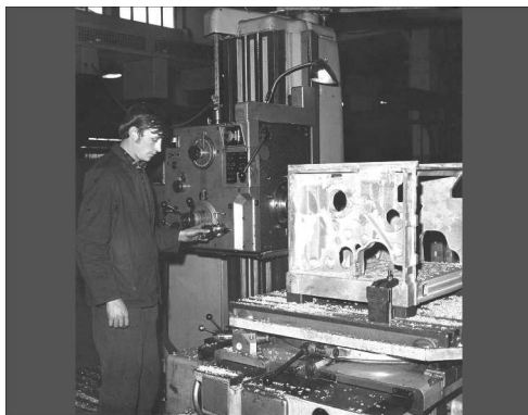
222. Obróbka korpusu mechanizmu drukującego
